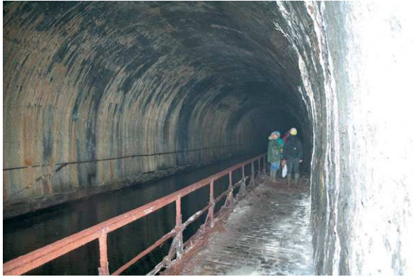
FIG. 4a – Tunnel de Godarville, vue générale (photo A. Dubois).
