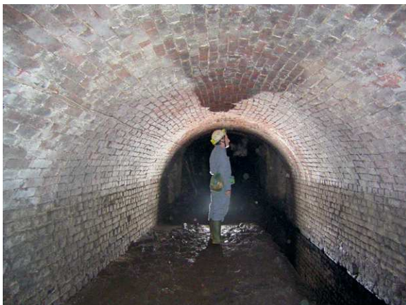
FIG. 1a – La Chartreuse, partie maçonnée (photo Gaëtan Rochez).
