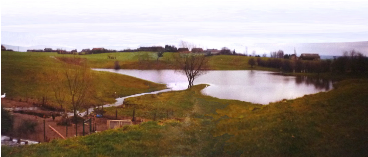
PHOTO 1 – Wooz. La grande dépression en période pluvieuse (Photo : Francis Polrot).
