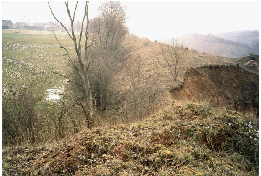
FIG. 21. – Carrefour des travaux de recherche 1859–1861 (fig. 4, p. 156, et 5, p. 158, point ⑥ sur la figure 1, p. 146). La haie longe le chemin au nord; les remblais, à droite, sont plus récents (travaux carriers?).
