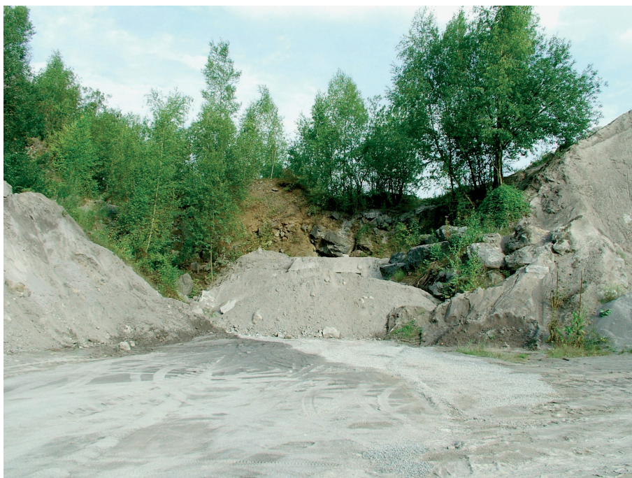
Construction de la nouvelle entrée et intégration au paysage. Photos : Chercheurs de la Wallonie.
