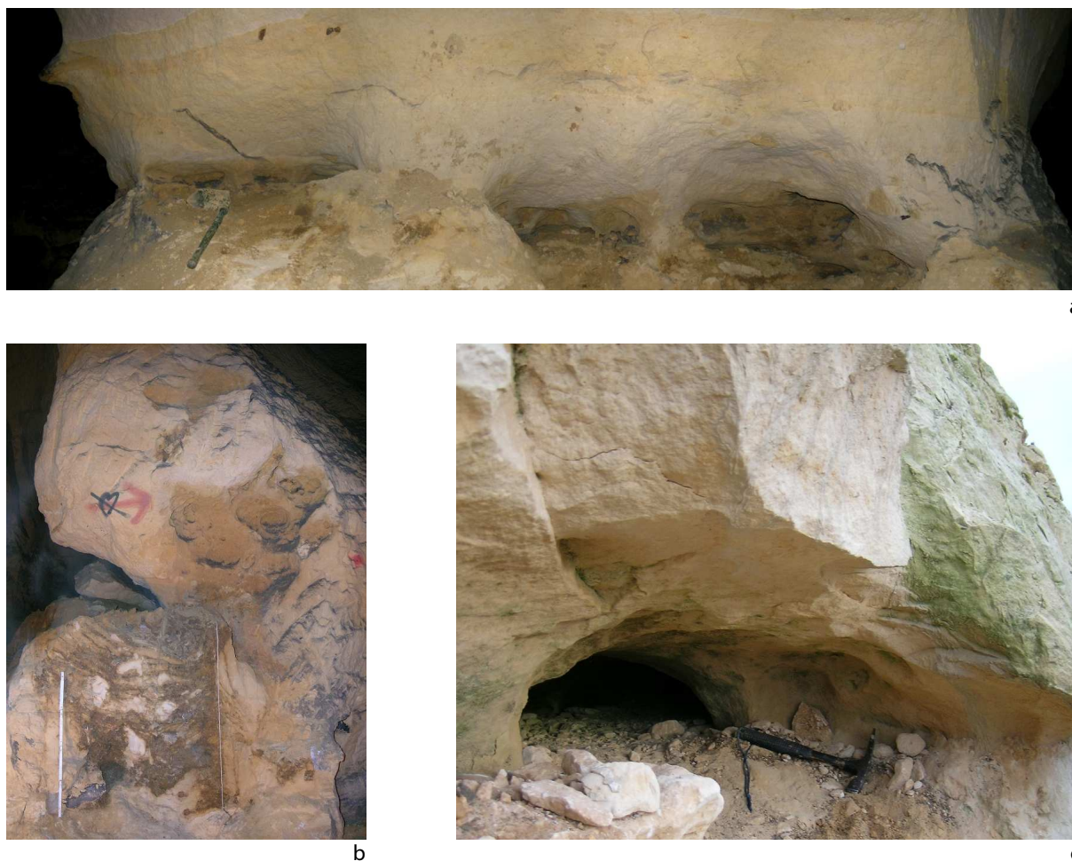
FIG. 6. – a. Grotte naturelle recoupée par des galeries artificielles. Détail de la galerie du CRSOA : extension latérale sous forme d'alvéoles emboîtées. (Photo L. Willems.) b. Grotte naturelle recoupée par des galeries artificielles. Détail de la galerie du CRSOA : partie de la grotte remblayée montrant notamment des structures de chenaux d'écoulement. (Photo L. Willems.) c. Chambre et conduit naturel dégagé une vingtaine de mètres sous le contact Tertiaire/Crétacé, dans les calcarénites du Romont. (Photo L. Willems.)
