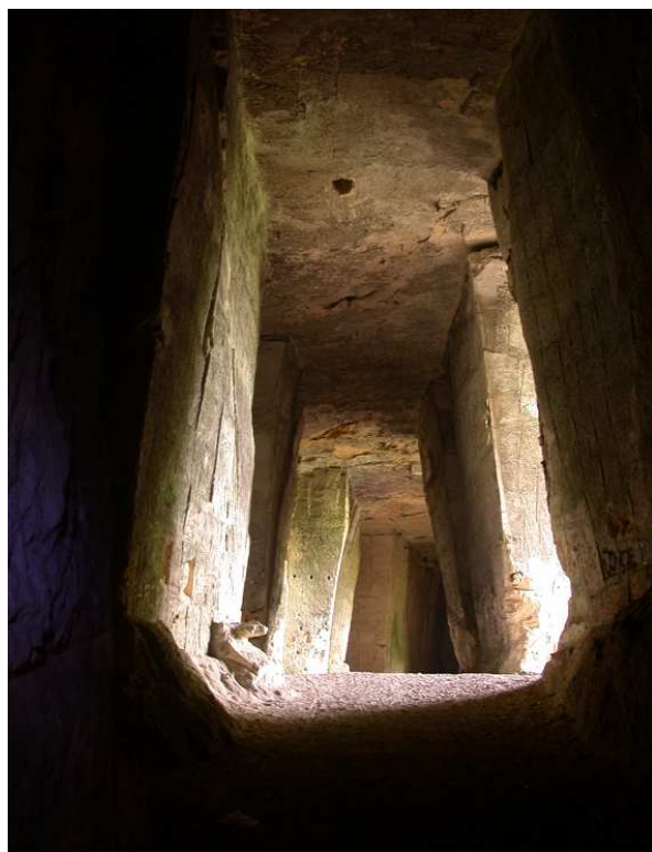
FIG. 2. – Exemple de galeries à section rectangulaire, carrière de Petit-Lanaye inférieure (Photo L. Willems).
